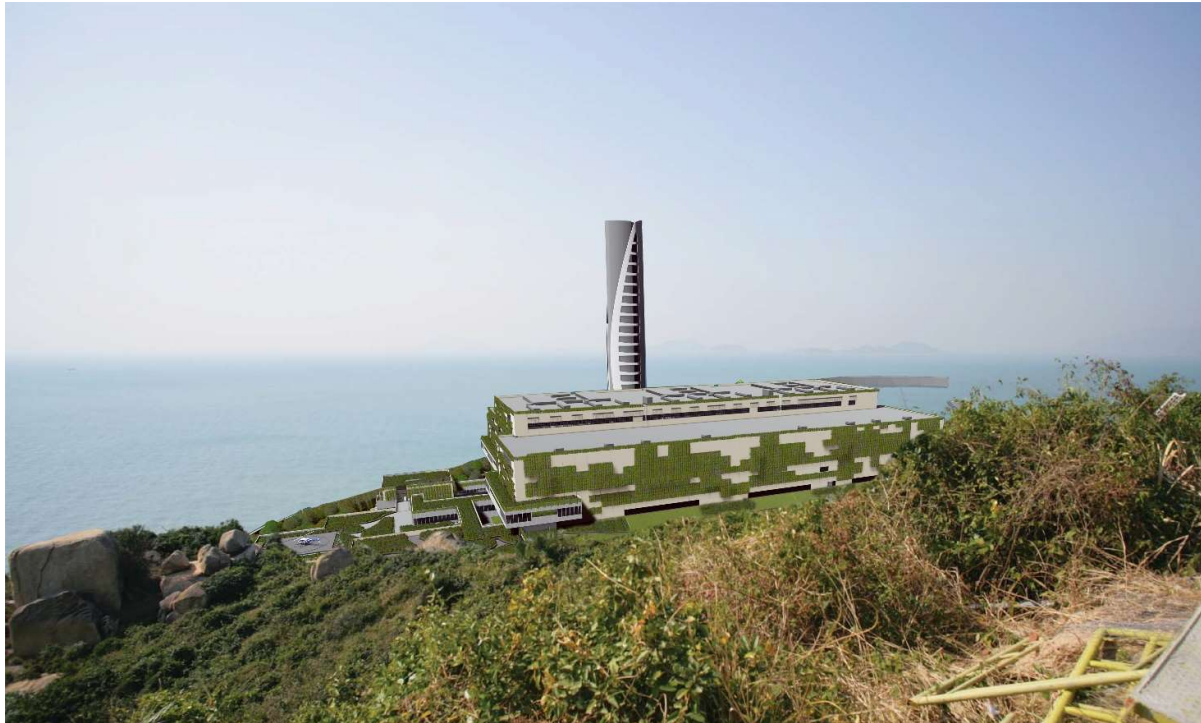
VSR 2 Shun House
