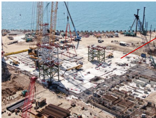
主焚化爐大樓鋼結構
