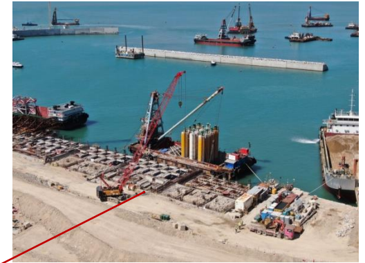
沉箱加高建造
