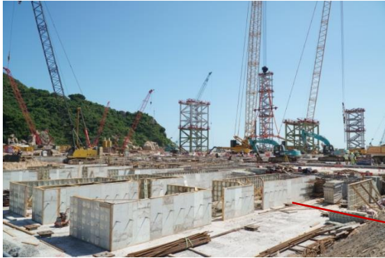
鍋爐廠房樁帽施工
