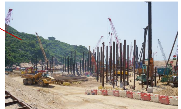
地基打樁施工
