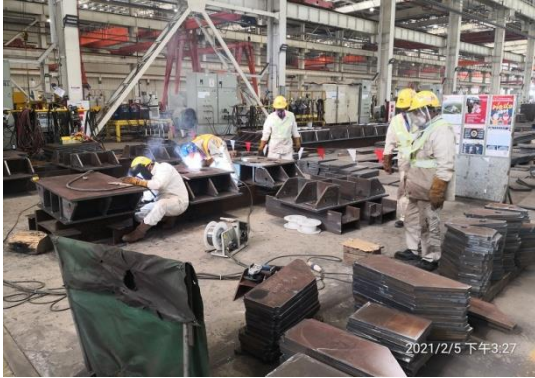
珠海預製場的鋼材 切割
