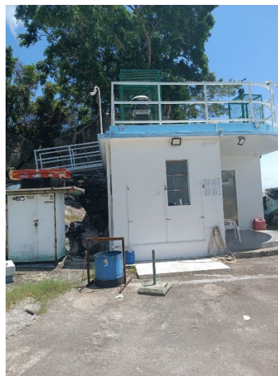
大嶼南空氣監測站
