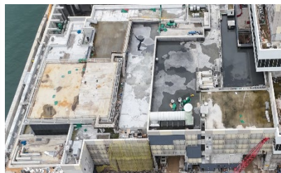
機械分類設備安裝 進行中
