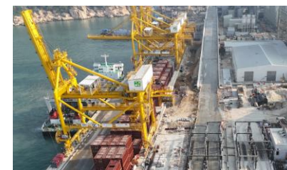
岸吊調試及試運行中
