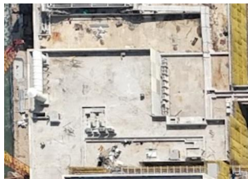
機械分類設備安裝進行中
