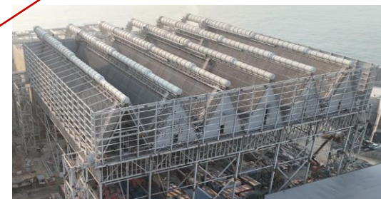
風冷式冷凝器調試進行中
