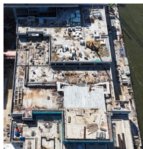
機械分類廠結構 施工完成，設備 安裝進行中
