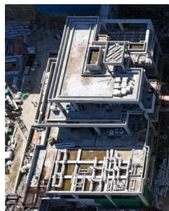
行政樓結構 施工完成
