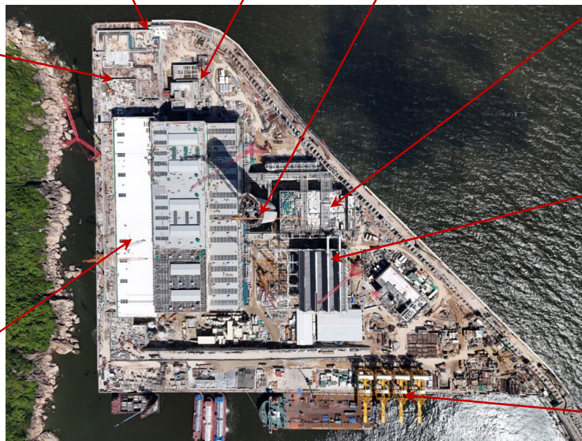
煙囪結構完成，鋼 平及台煙氣管道安 裝進行中
