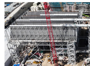
風冷式冷凝器安裝進行中
