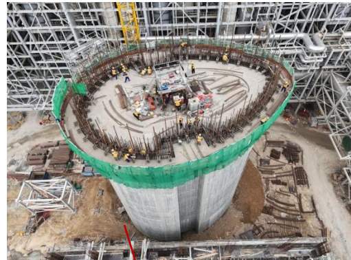
煙囪建造 進行中
