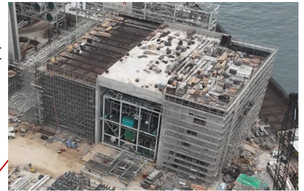
渦輪發電站上部結構施工進行中
