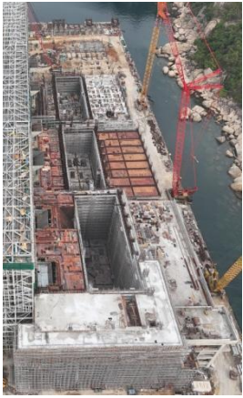
廢物儲存槽 建造進行中
