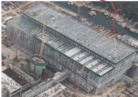
主焚化爐大樓鋼結構及 所有預製組件交付完成!
