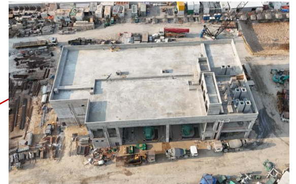
變電站結構施工已完成，正進行 內部裝飾及設備安裝
