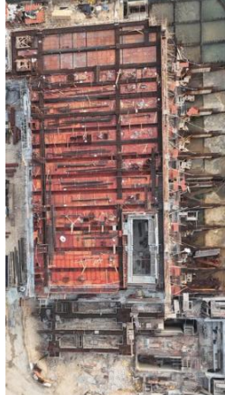
海水化淡廠 建造進行中
